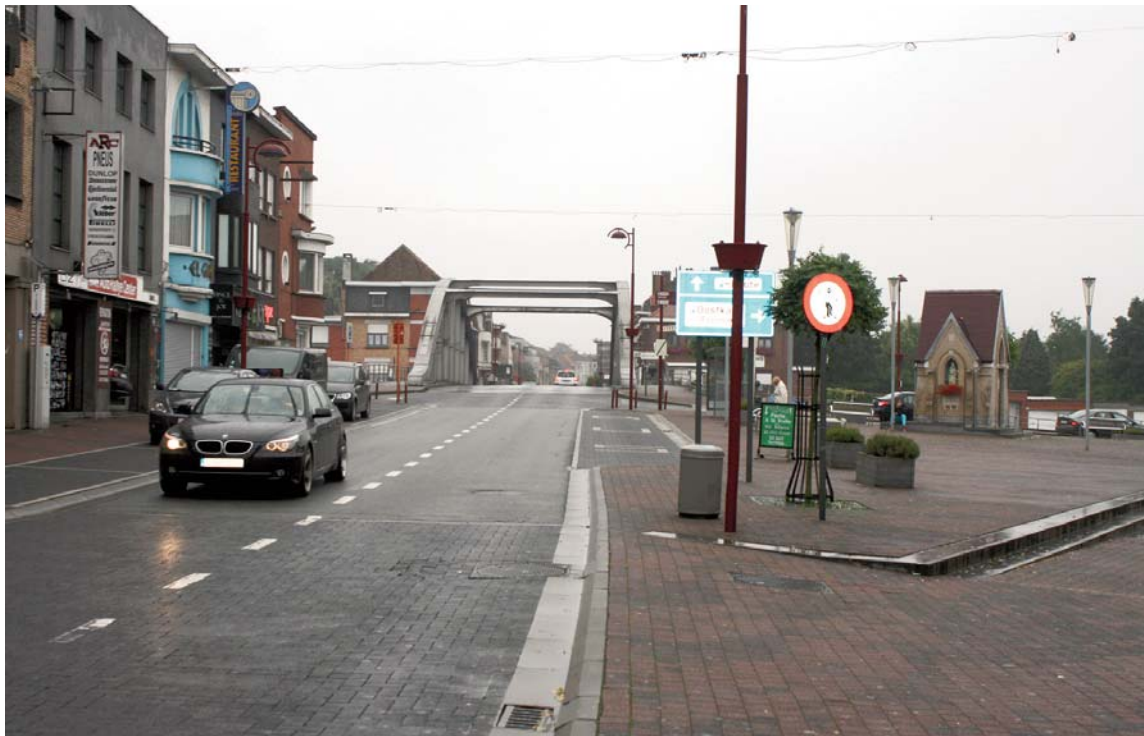
In het centrum van de Barakken moet een nieuwe brug gebouwd worden en dat zal zijn gevolgen hebben voor de hele buurt. (Foto CR)
