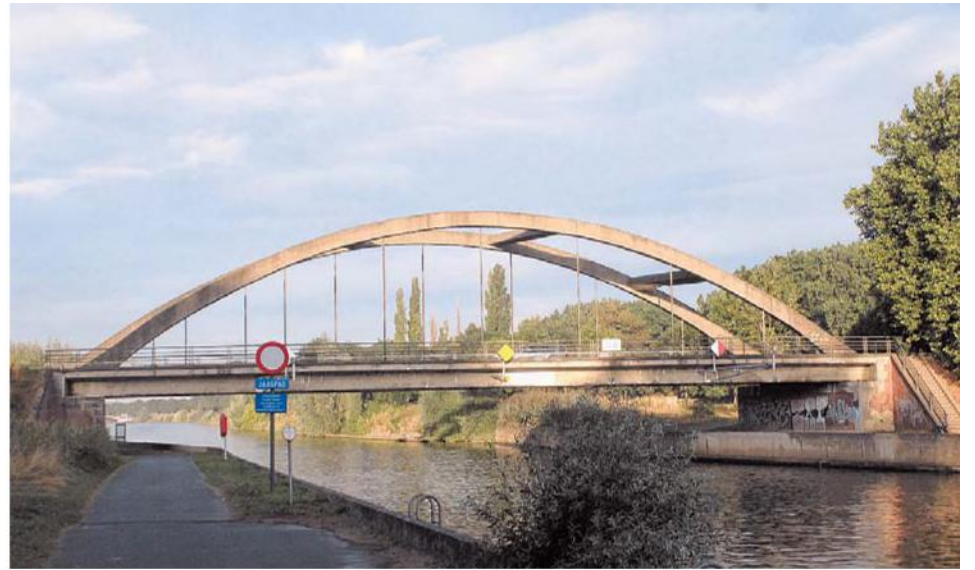
De Leiebrug tussen Lauwe en Wevelgem: daar zullen de aanpassingen het minst ingrijpend zijn. (Foto Wilfried Ossieur)
