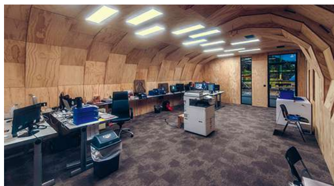
QuadriVille, de 100% herbruikbare kantoorruimte in de XXL-afdeling, gebouwd met FSC gecertificeerd hout en met spanbanden. Het vertrekpunt van het gebouw in het gebouw is een vierkant van vier op vier. De constructie van QuadriVille is een vermenigvuldiging of deling van dit vierkant.
