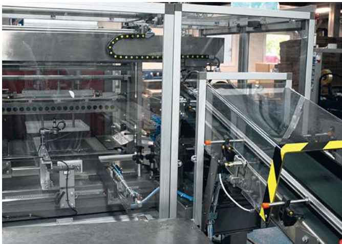
De aanvoer van de doosjes richting automatische bundelverpakker.
